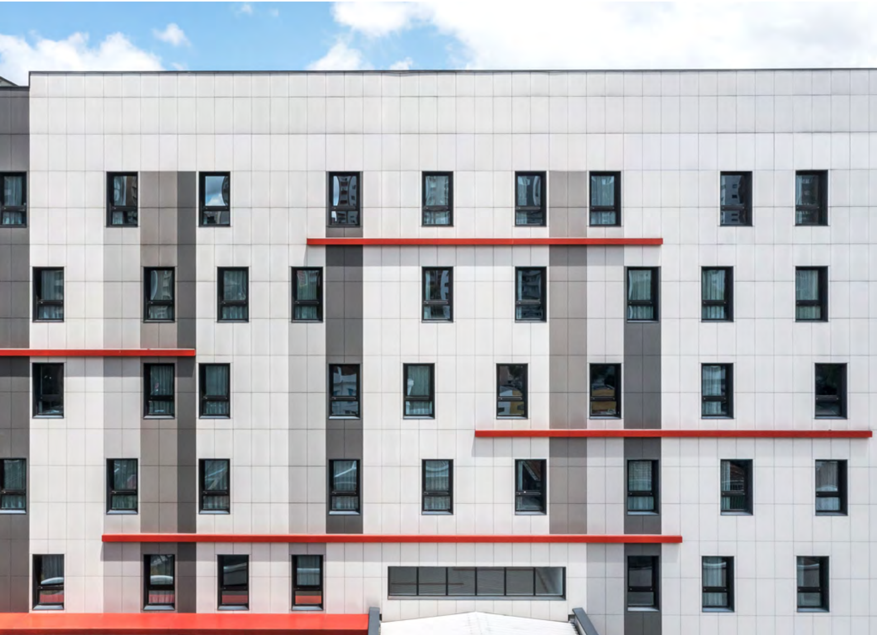
Fachada: Munari Branco AC 60x120cm | Munari Concreto AC 60x120cm | Munari Cimento AC 60x120cm | Projeto: Hotel Moov | Foto: Eduardo Macários
